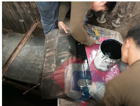
รูปที่ 11 ทากาวและติดแผ่นยาง Intermediate
