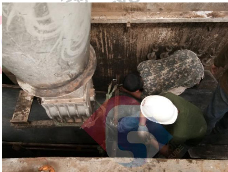
รูปที่ 10 วัดสายพานให้มีความยาวที่พอดีกับระบบลำเลียง
